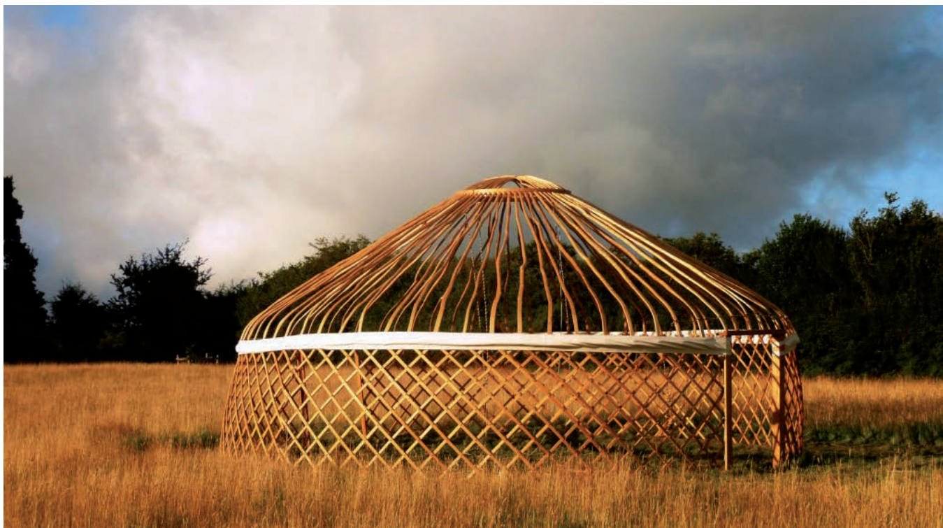
Κατασκευή αναδυσόμενου πολυχώρου.
